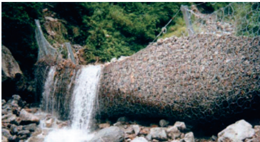
图1 泥石流柔性防护系统 [8]
